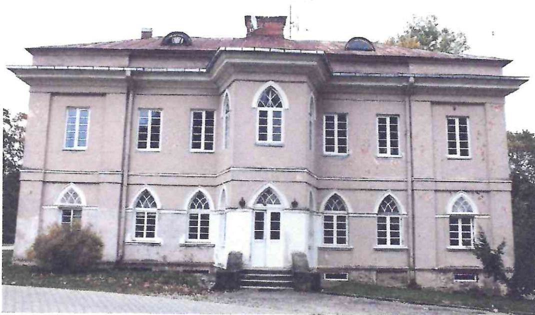
Foto Nr.1 Vakarinis fasadas
